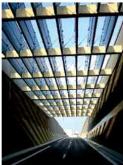
Photo 7 : un damier phonique (source : Les écrans acoustiques – Guide CERTU - 2007 - [16])
